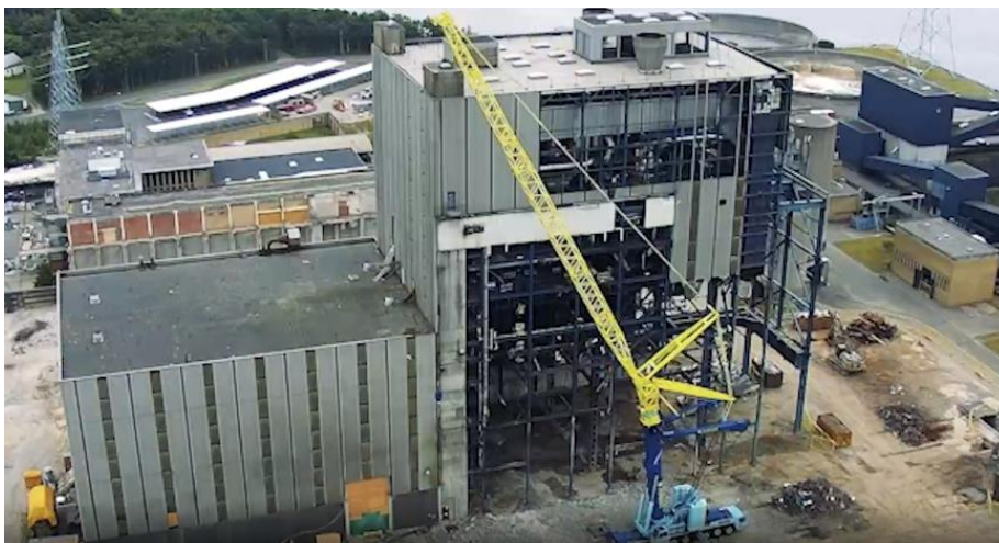
Figur 20: Nedrivningsprojekt på Nordjyllandsværket.
